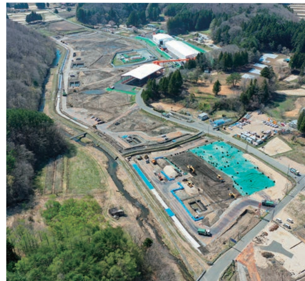
再生利用実証事業の様子(2021年4月撮影)
