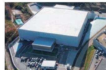
廃棄物貯蔵施設(双葉1工区)
