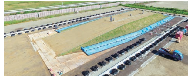
試験盛土の様子(2017年9月撮影)
