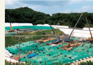
特定廃棄物埋立処分施設
