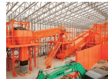
再生資材化施設
