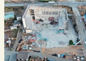
双葉町公民館・体育館の解体作業
