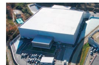
廃棄物貯蔵施設(双葉1工区)
