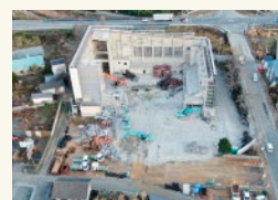
双葉町公民館・体育館の解体作業
