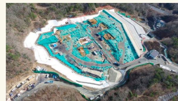
特定廃棄物埋立処分施設（富岡町）
